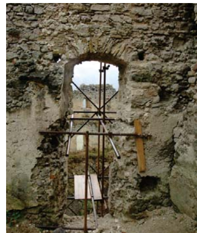
Obnovené špalety a záklenok z interiéru
