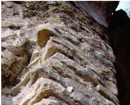
Detail vrcholu novej špalety v mieste zapretia do pôvodného muriva
