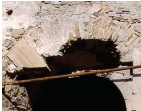
Záber na obnovený záklenok brány
