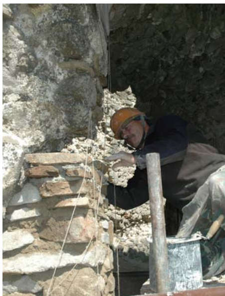
Snímky z priebehu konzervácie. Vľavo: Murovanie špalety v priestore brány. V strede: Aktivácia záklenku na prvom poschodí. Vpravo: Po realizácii
