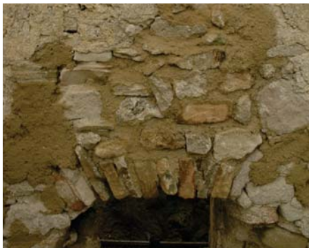
Obnovený záklenok prvého poschodia
