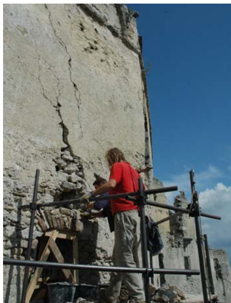
Snímky z priebehu konzervácie. Vľavo: Murovanie špalety v priestore brány. V strede: Aktivácia záklenku na prvom poschodí. Vpravo: Po realizácii
