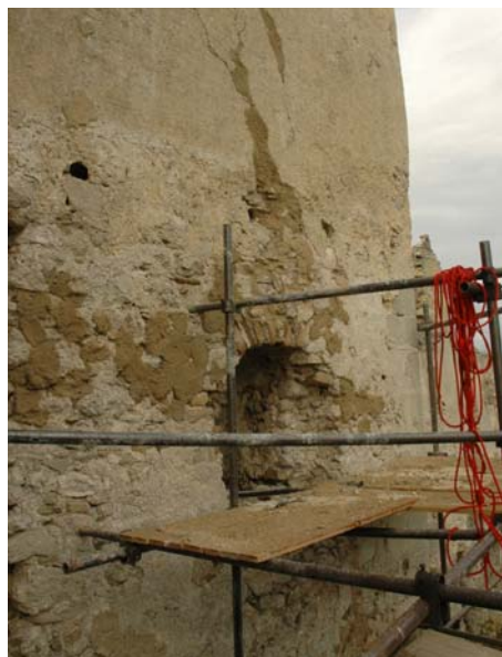
Snímky z priebehu konzervácie. Vľavo: Murovanie špalety v priestore brány. V strede: Aktivácia záklenku na prvom poschodí. Vpravo: Po realizácii
