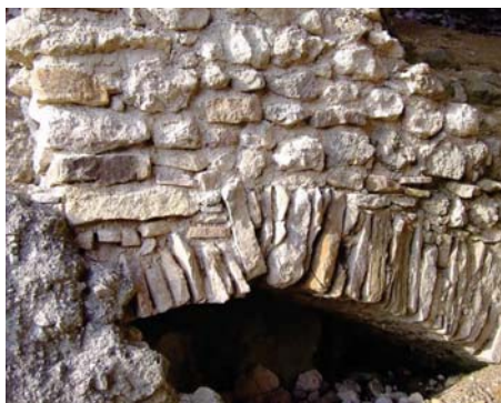
Preklenovací pás, ktorý musel byť obnovený, aby bolo možné vymurovať chýbajúcu špaletu
