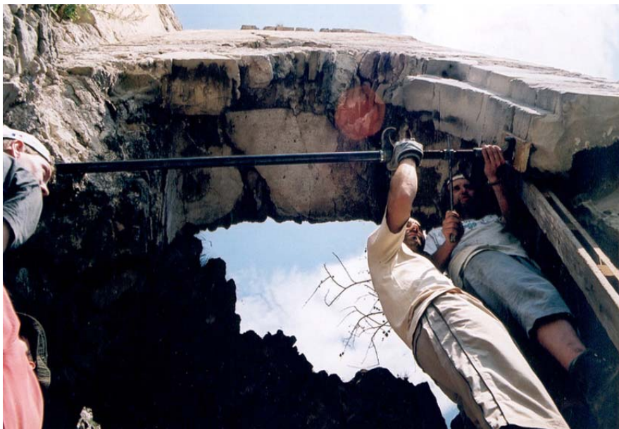
Instalace rozpěry v gotické bráně. Dobře viditelné poruchy vlevo a ve vrcholu portálu.
